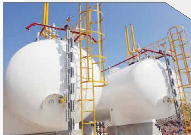
Bồn chứa ngang, hệ thống xử lý nước - Nhà máy sữa đậu nành VINASOY Bắc Ninh Horizontal tank, water treatment system - VINASOY Bac Ninh Soy Milk Factory 卧式水箱、水处理系统 - VINASOY 北宁豆浆厂
